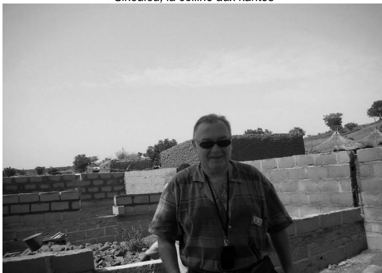
Sikoulou en construction
