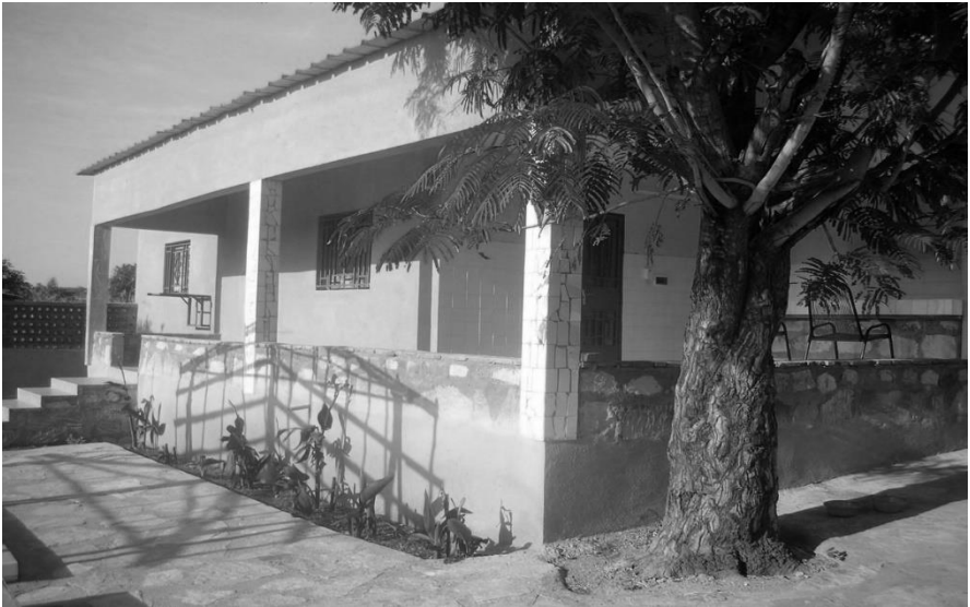
La maison avec la terrasse Sikoulou
